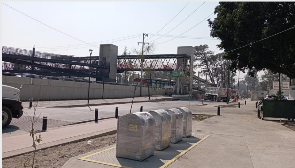
ESTACIÓN SAN JUAN DE OCOTÁN
